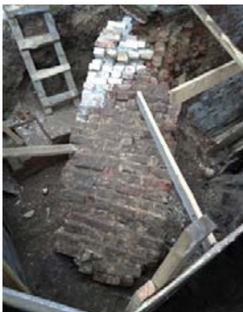
Рис. 1. Общий вид отремонтированной кирпичной арки-спуска в подвальную часть Главного дома (осень 2019 г.). Фото автора
