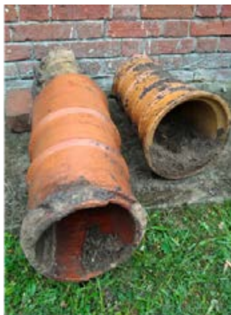
Рис. 2. Керамические трубы канализации Главного дома замка, поднятые со дна котлована. Фото автора.
