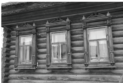
Старинный деревянный дом. Фото 2013 г.
