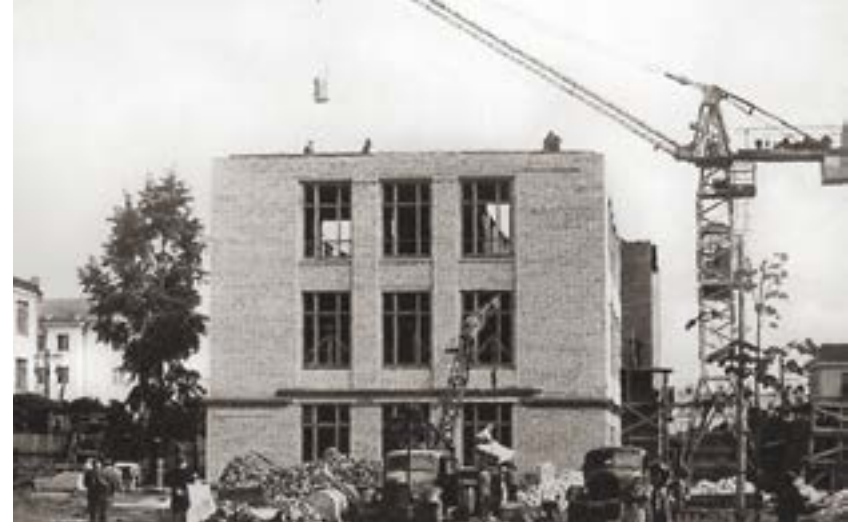
Идет реконструкция музея. 1960 г.
